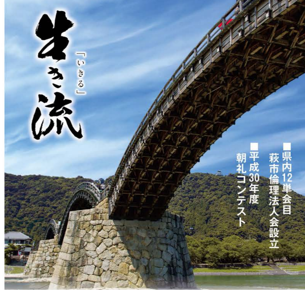
【錦帯橋】山口県岩国市 川幅約200メートルの河川内に4つの橋脚を持つ5連の木造橋で、中央3連がアーチ橋、両端が桁橋構造を持つ反橋となっていて、日本三名橋に数えられる勝に指定されている。
